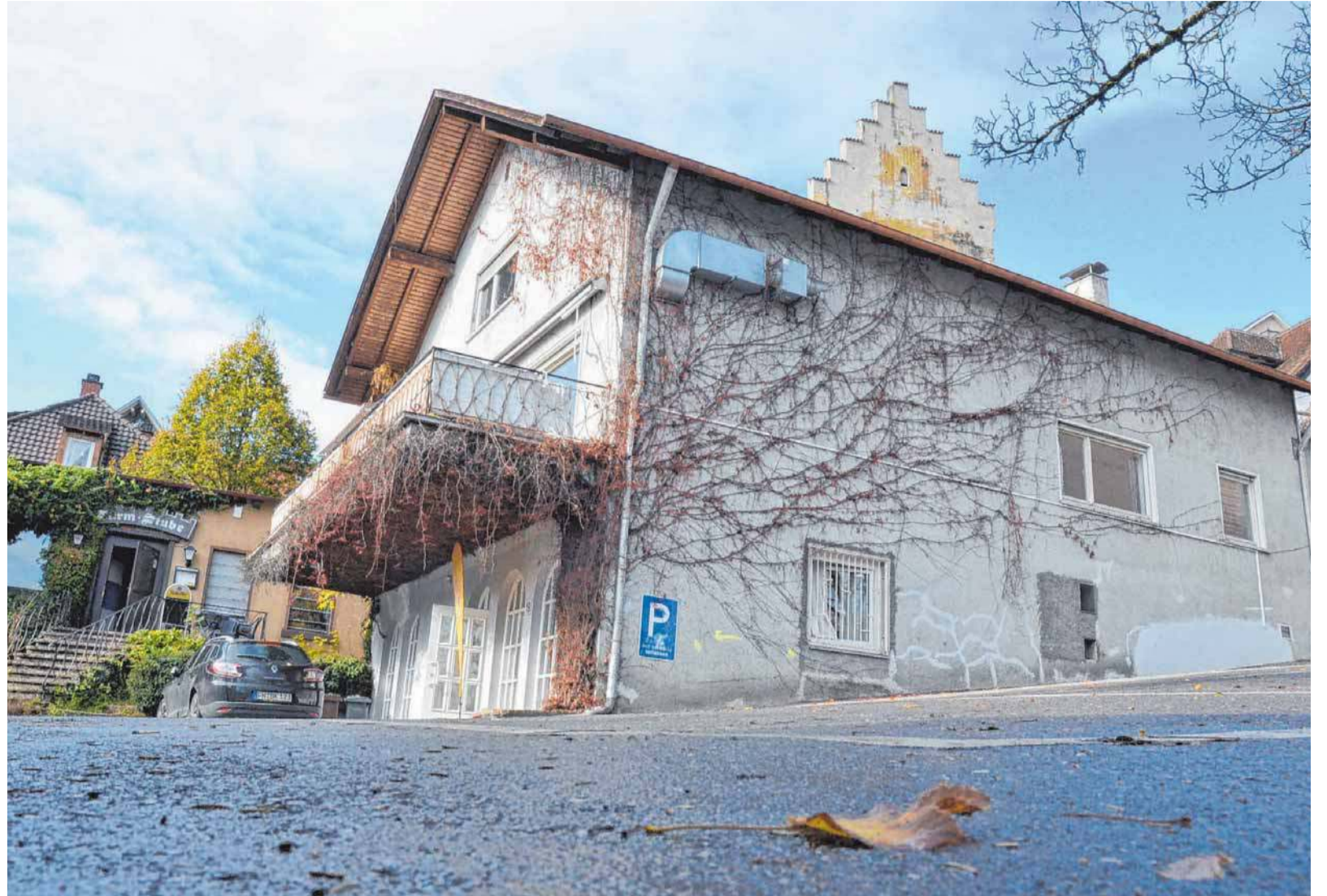
Die Gebäude rund um den Hexenturm sollen weg, damit die Fahrzeuge zur Baustelle am Bischofsschloss können.
